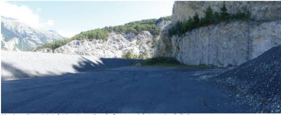
Vue 6 : partie aval de la falaise et zone d'accès. Paysage minéral, peu de végétation
