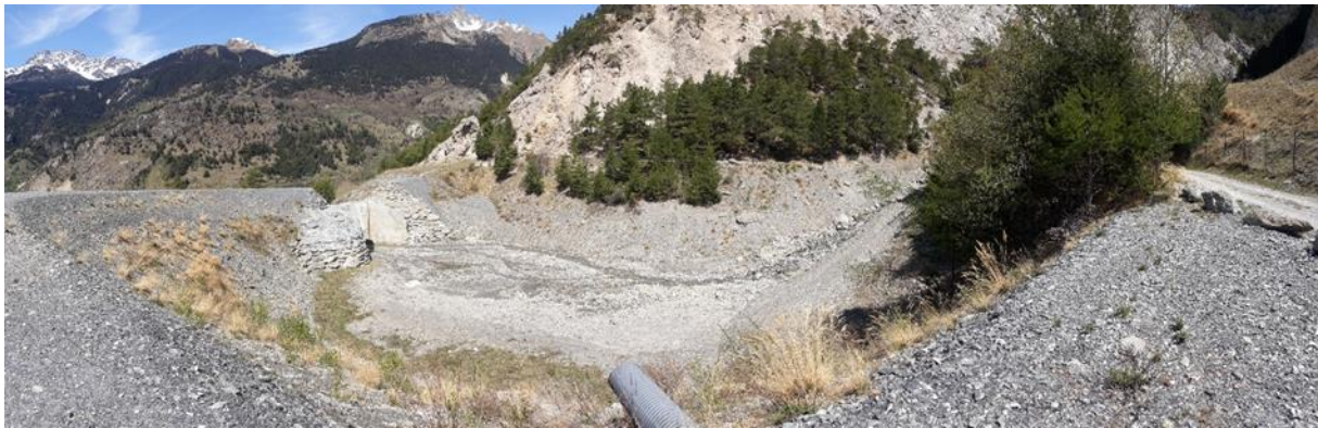
La plage de dépôt en aval de la zone ayant fait l'objet des investigations
