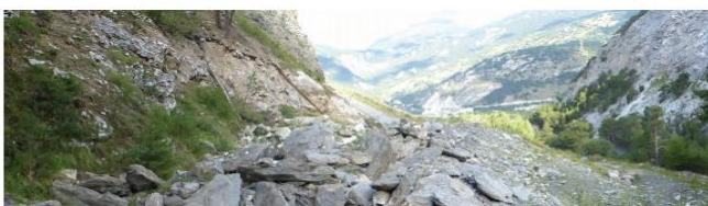
Vue 3 : entrée de la carrière depuis le ruisseau Saint-Antoine à l'est du site, zone d'éboulis
