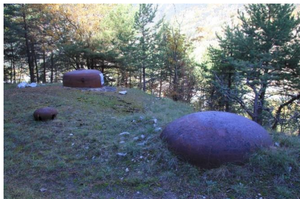
Blockhaus au sein de la zone d'étude Source : ATDx
