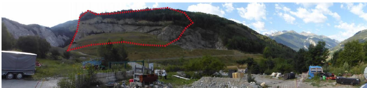
Vue 1, en aval de la carrière, depuis la route d'accès au site Source : KARUM Actions Nature
