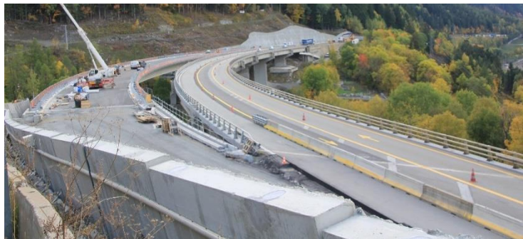
Travaux du viaduc du Charmaix Source : ATDx (11/10/2022)
