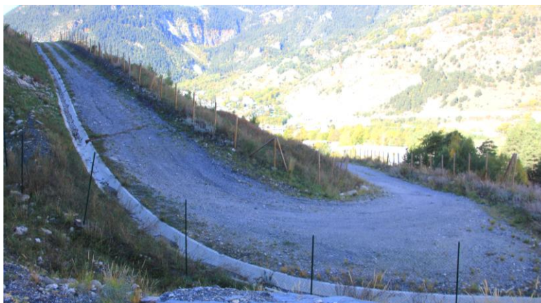
Aménagements hydrauliques au droit de la piste d'accès au site sur les remblais de l'ISDI Source : ATDx
