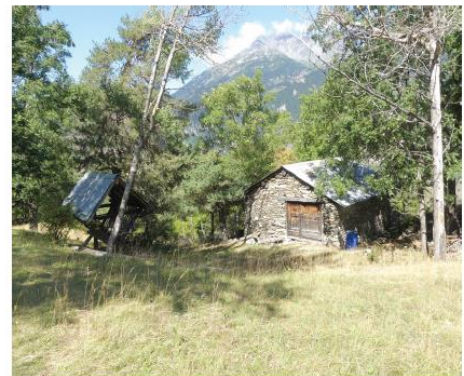
Vue 11 : patrimoine bâti, chalet d'alpage à l'architecture typique de la Haute-Maurienne
