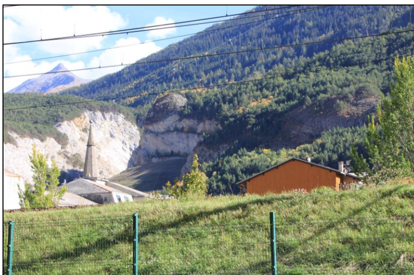
Vue vers le site du projet depuis l'ancienne rizerie des Alpes Source : ATDx (11/10/2022)
