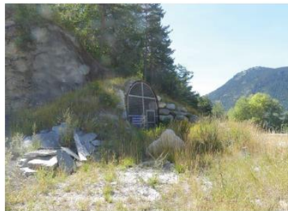
Vue 16 : accès piéton vers le tunnel au Frejus (galerie)
