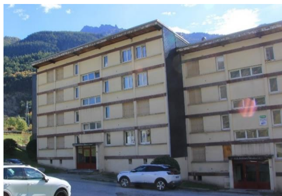
Résidence rue de l'Iseran Source : ATDx
