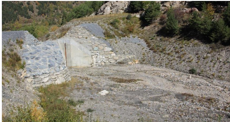
Barrage sur le cours d'eau Saint-Antoine Source : ATDx (11/10/2022)
